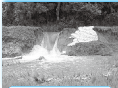
岩淵用水路(末端)の法面崩壊 (栗駒猿飛来地内)
