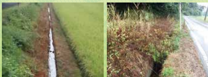
【除草剤を散布した法面は、崩れやすい?】
