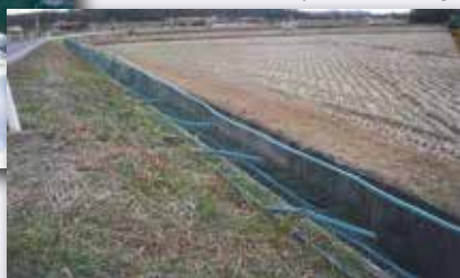
フェンスがなぎ倒されている
